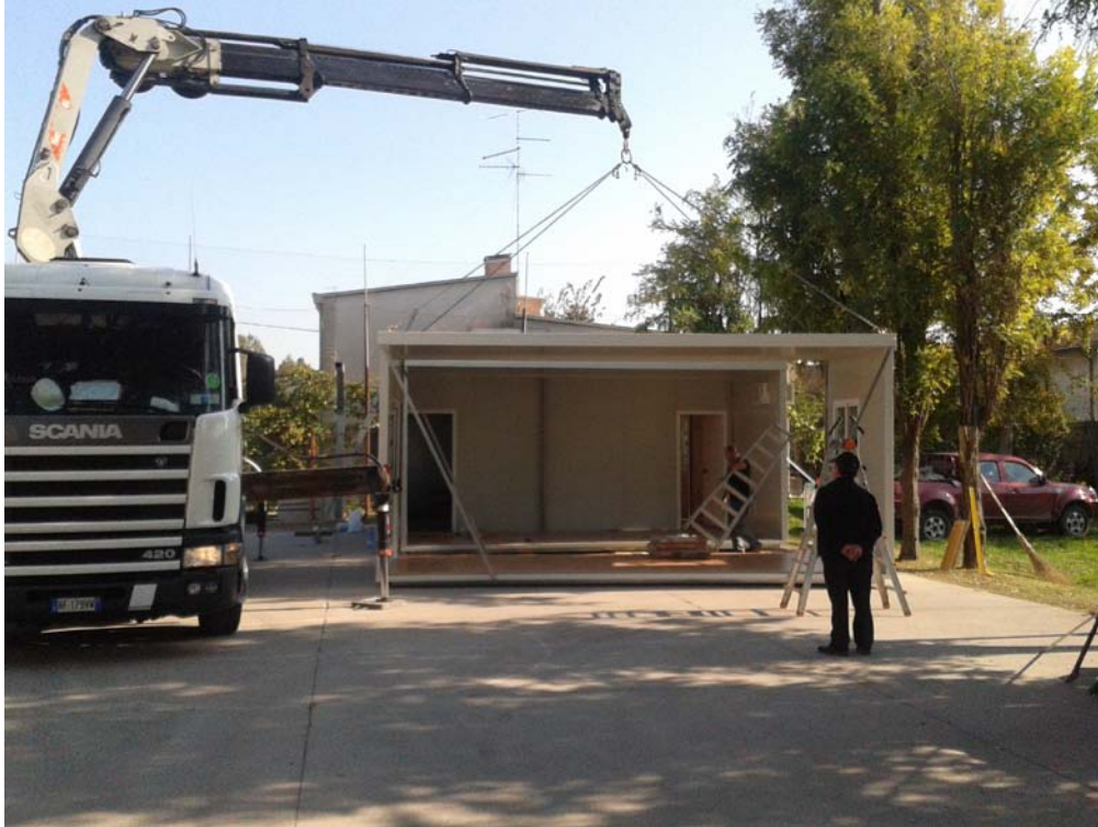
Posa dei prefabbricati adibiti ad uffici parrocchiali
