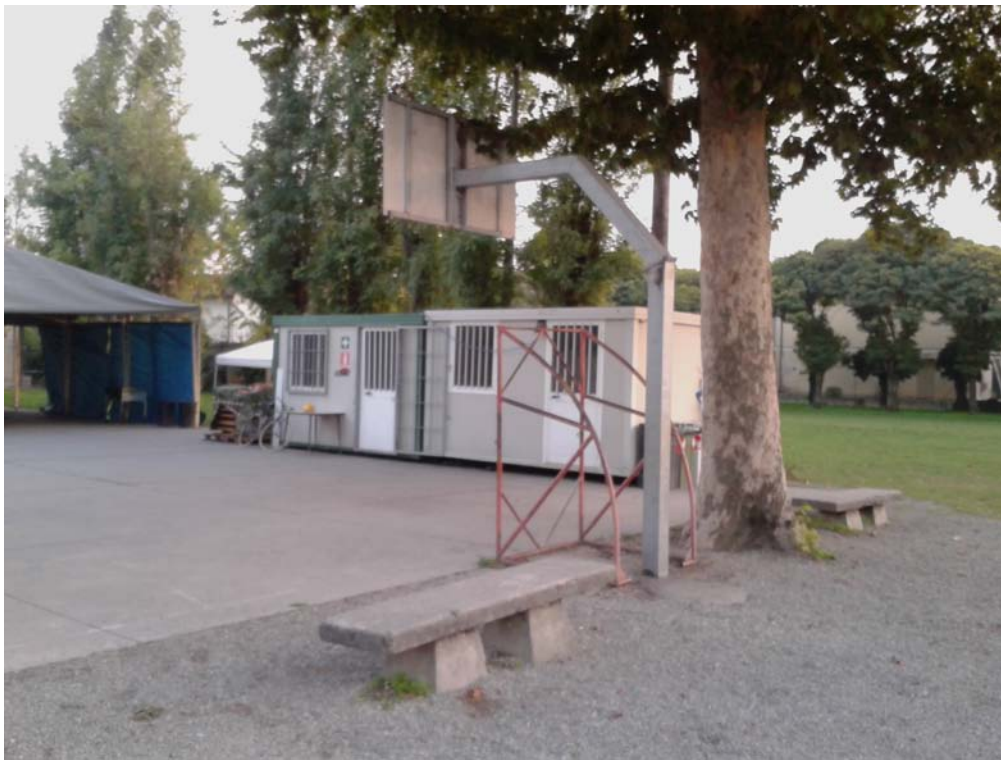
Attuale sistemazione dei prefabbricati adibiti ad uffici parrocchiali
