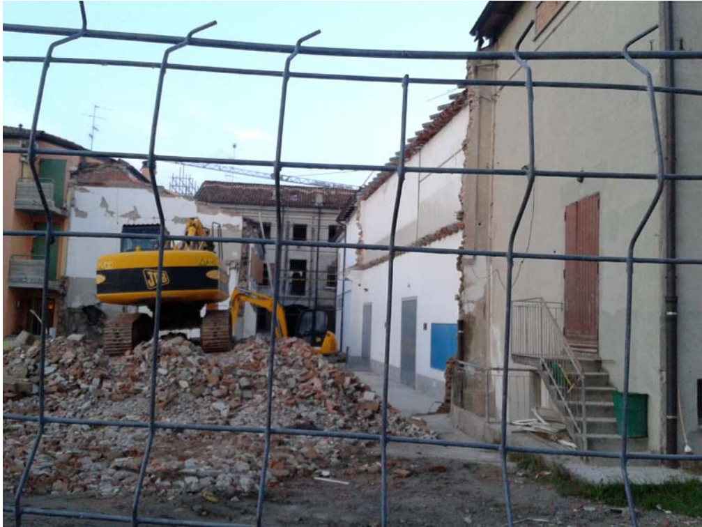
Demolizione delle strutture più danneggiate della parrocchia e dell'oratorio
